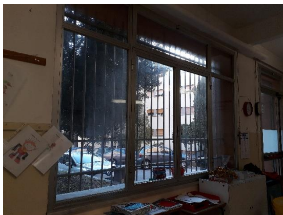
Figura 4.3 - Particolare dei serramenti in alluminio
