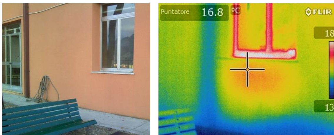
Figura 4.4 – Rilievo termografico serramenti
