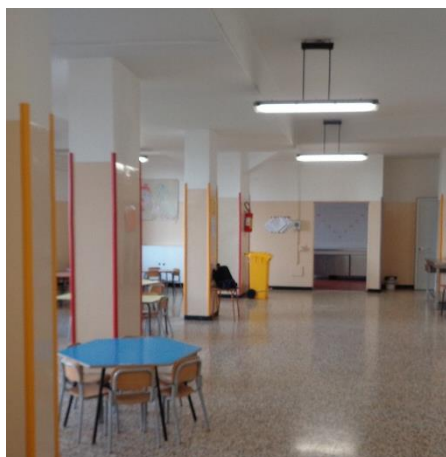
Figura 4.15 - Particolare dei corpi illuminanti ubicati nella mensa
