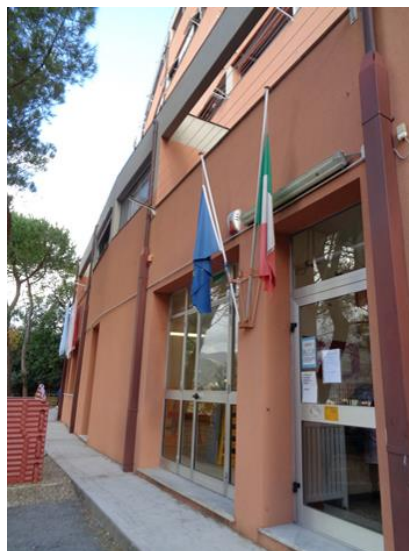
Figura 1.1 - Vista della facciata Nord-Ovest
