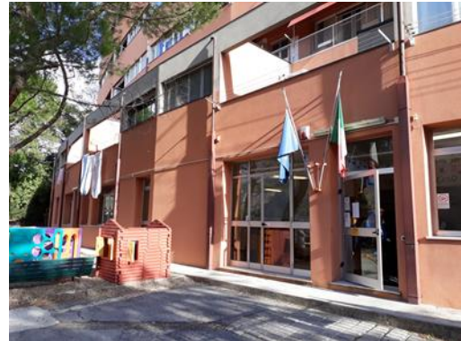
Figura 4.1 - Particolare facciata sud-ovest fabbricato
